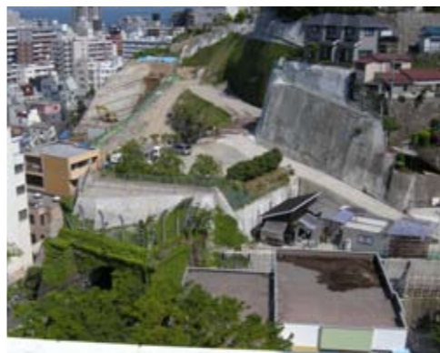
写真は若松3丁目の地区計画地。左下が京急中央駅南のトンネル、手前の屋根は児童図書館
